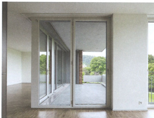
Die Hauptwohnräume: Die Ausdehnung orientiert die Wohnungen aneinander vorbei und in die landschaftliche Tiefe statt zum Gegenüber.
