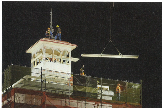
■ In der Nacht vom 9. auf 10. Oktober 2016 konnte auch die Aufrichte des Turms fertiggestellt werden.
