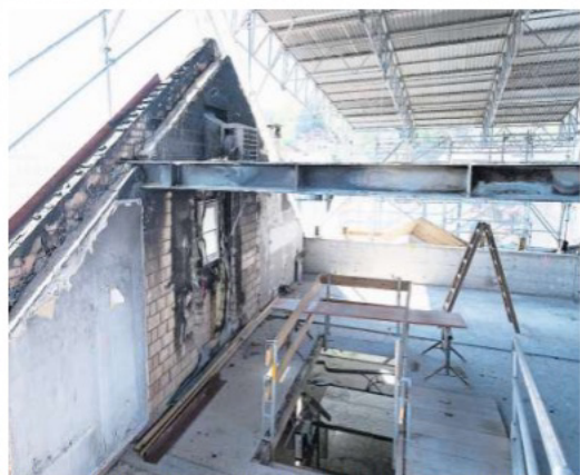
Oben: Das Hotel Schlüssel am Franziskanerplatz ist nach wie vor eingerüstet. Unten: Während Gipser im Erdgeschoss Brandschutzbekleidungen anbringen, sind die Spuren des Brandes im Dachstock noch gut sichtbar. Bilder: Plus Amrein/Boris Bürgisser (Luzern, 30. April/1. Mai 2019)
