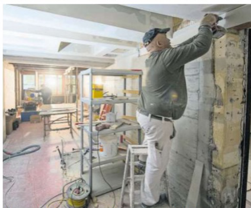
Oben: Das Hotel Schlüssel am Franziskanerplatz ist nach wie vor eingerüstet. Unten: Während Gipser im Erdgeschoss Brandschutzbekleidungen anbringen, sind die Spuren des Brandes im Dachstock noch gut sichtbar. Bilder: Plus Amrein/Boris Bürgisser (Luzern, 30. April/1. Mai 2019)
