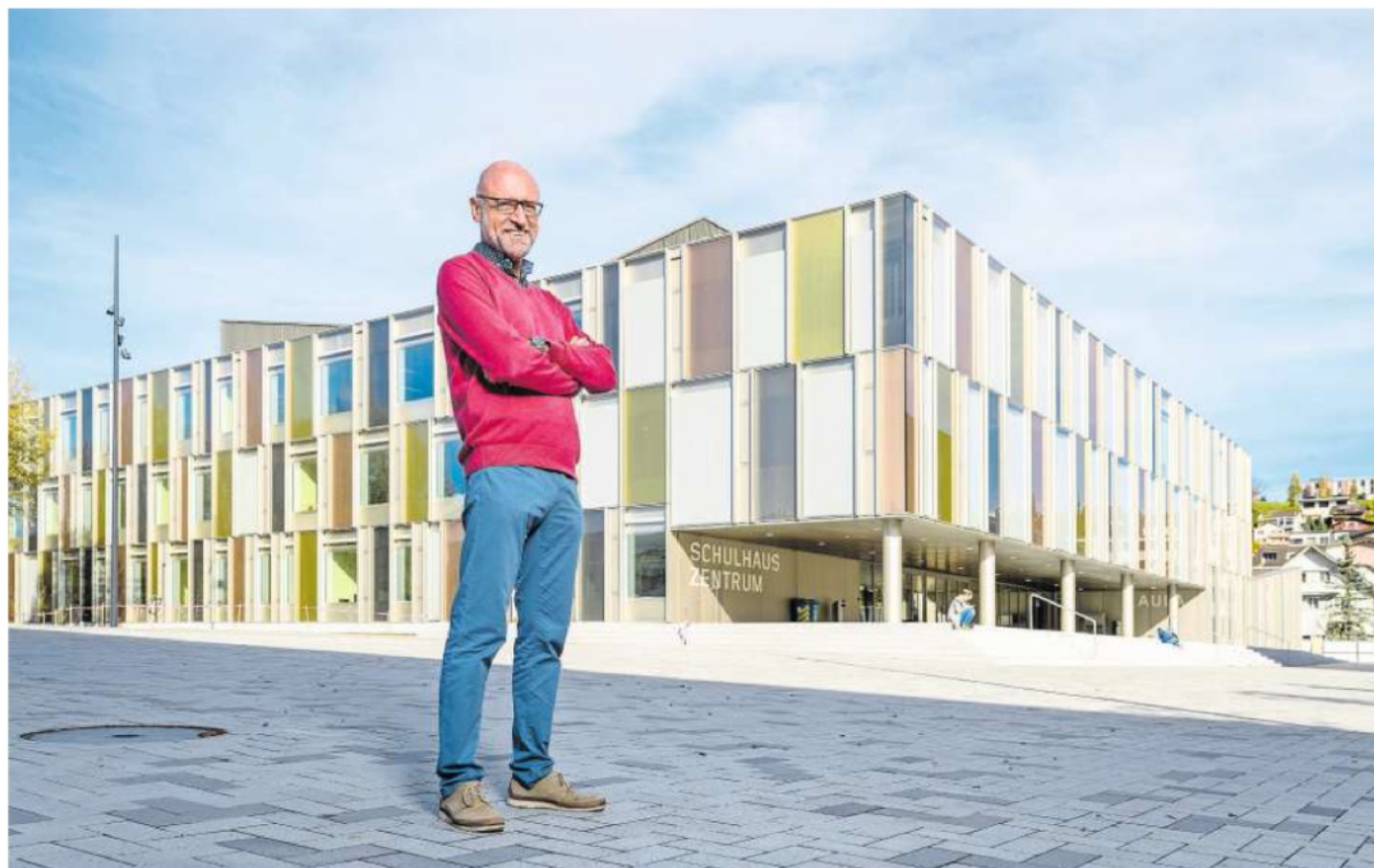
Schulleiter Thomas Hediger freut sich über das totalsanierte Oberstufenschulhaus im Horwer Zentrum.
