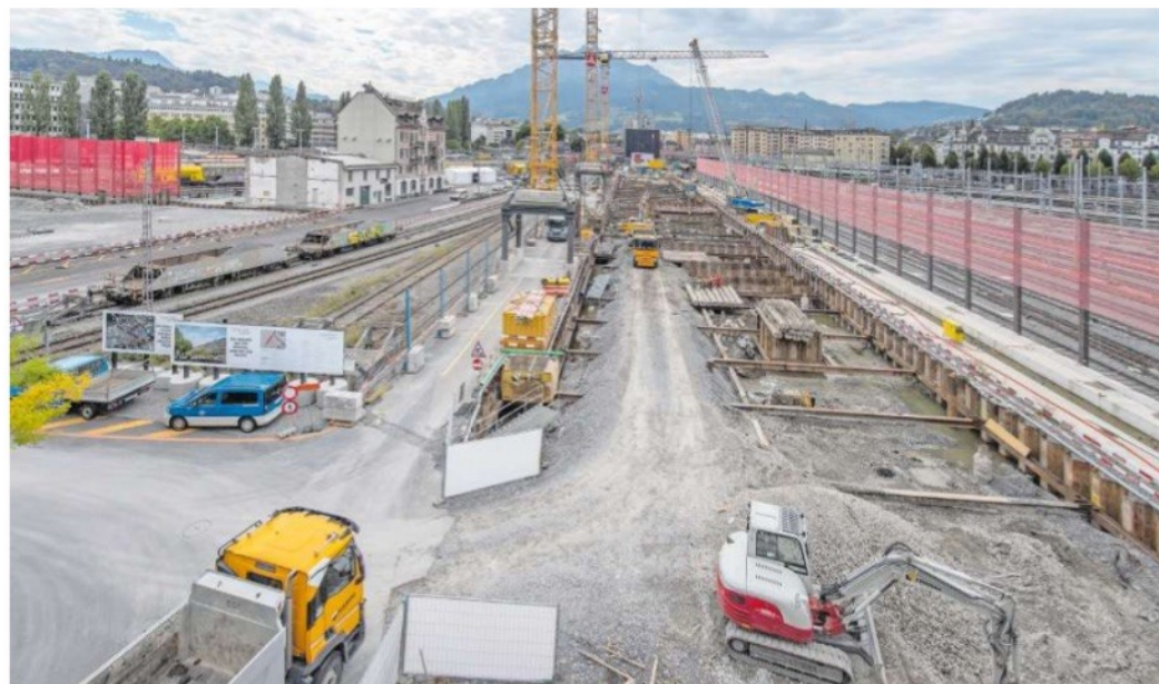
Blick auf die Baustelle des Baufelds A, links hinten ist das Haus an der Güterstrasse 7 zu sehen.
